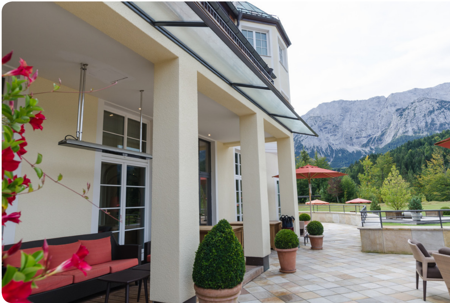
Terrassen-Installation, Schloss Elmau, Krün · Deutschland
